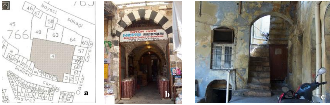
Şekil 1. Yapıya ait parselasyon planı (a) ve onarım öncesi fotoğrafları: giriş portalı (b), üst kata çıkış ve bodruma iniş merdivenleri (c) (Anonim, 2005: 155; Vakıflar Genel Müdürlüğü Arşivi)
